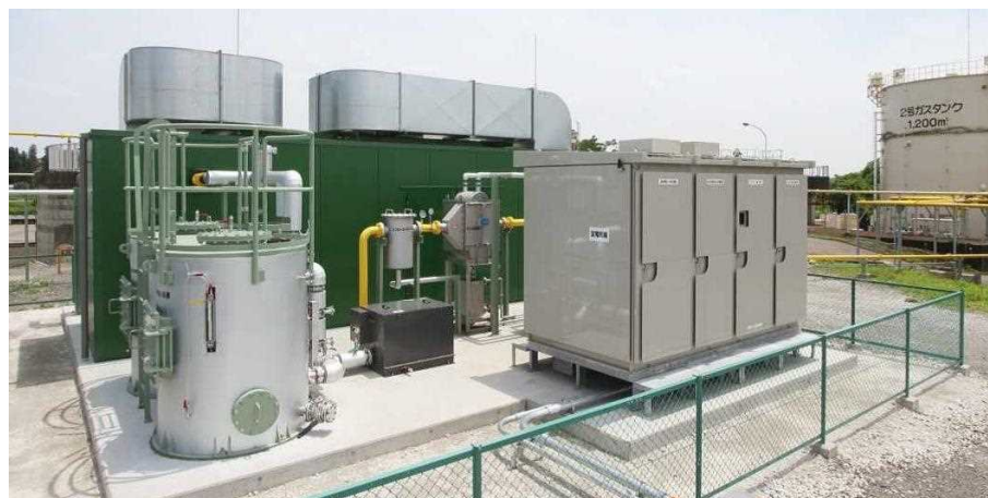
バイオガス発電を行う黒川消化ガス発電所
