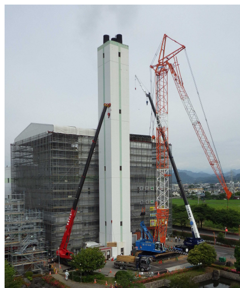
改良工事中の環境クリーンセンターごみ焼却施設
