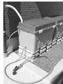
◀自主製作の雨水貯留槽
