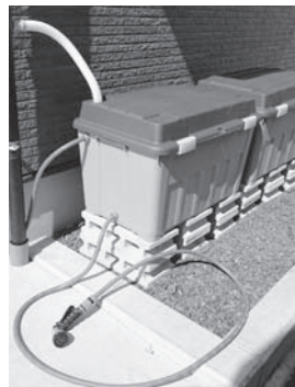
自主製作の雨水貯留槽
