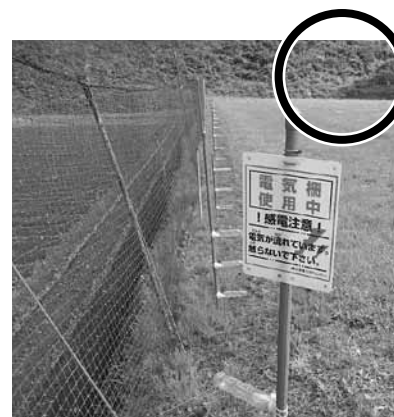
⑤ 電気柵等の侵入防護柵は、周辺を定期的に草刈するなど入念な維持管理をする。
