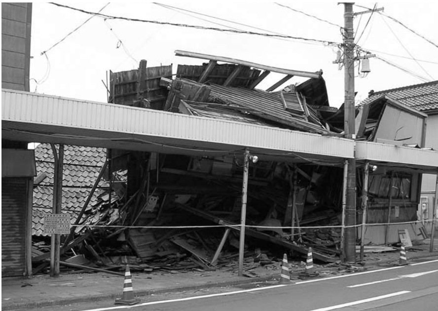
▲中越沖地震（平成19年7月）で倒壊した店舗
