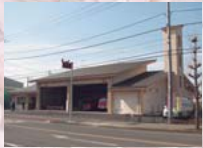
▲3/29 さつき町に消防署東分署完成
