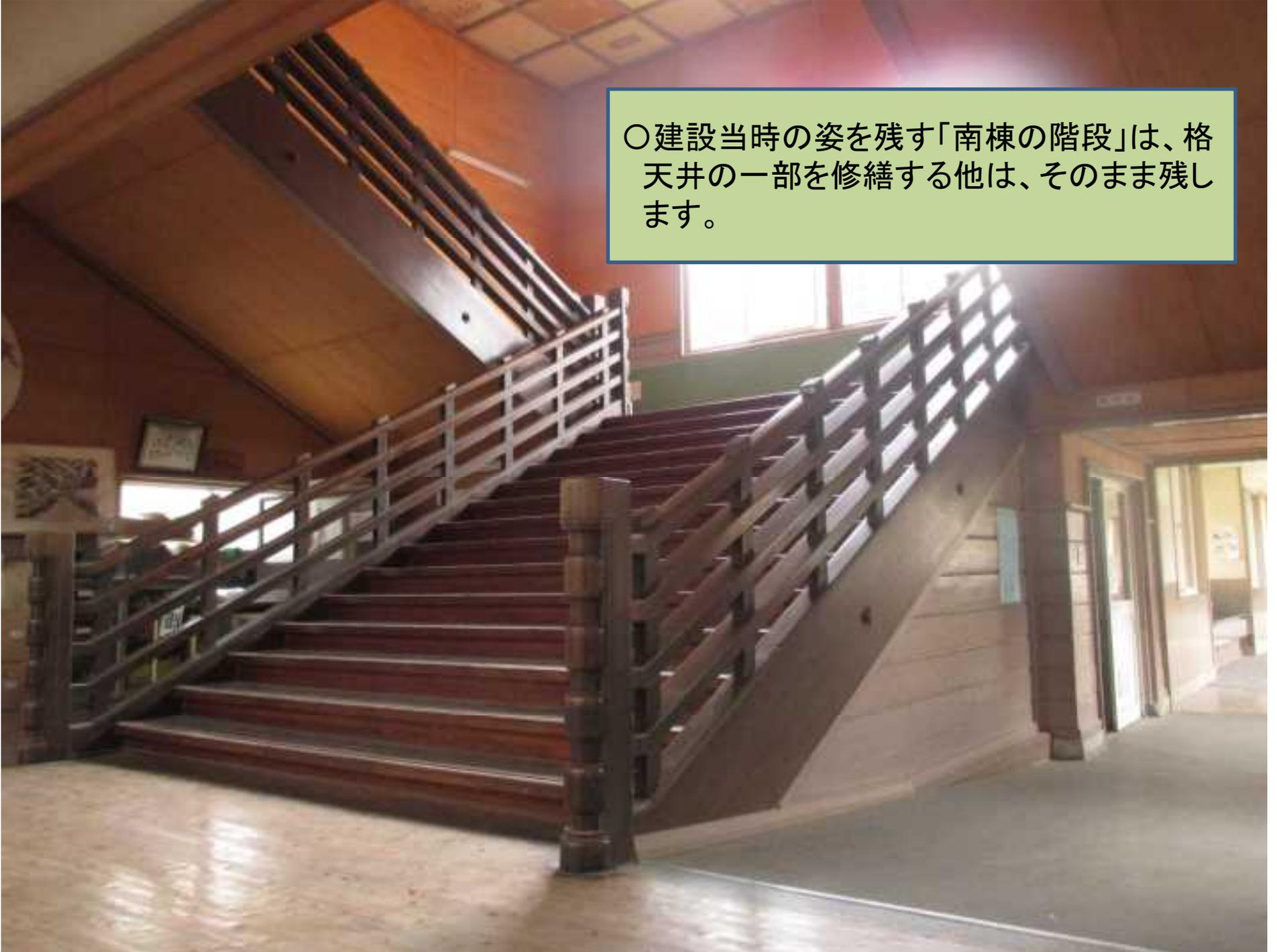
○建設当時の姿を残す「南棟の階段」は、格天井の一部を修繕する他は、そのまま残します。
