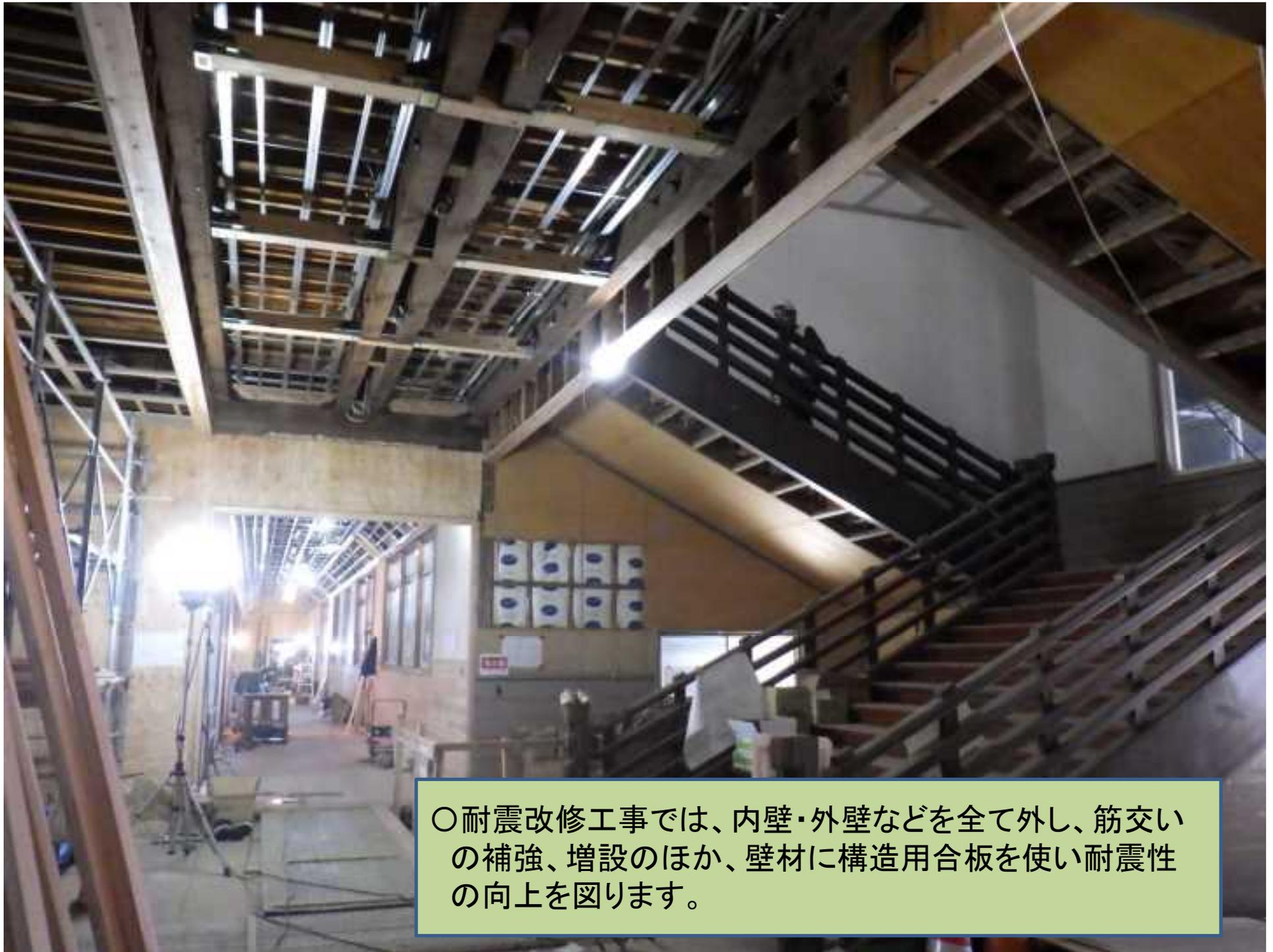
○耐震改修工事では、内壁・外壁などを全て外し、筋交いの補強、増設のほか、壁材に構造用合板を使い耐震性の向上を図ります。
