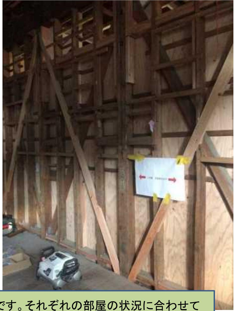
○内壁を全て外した様子です。それぞれの部屋の状況に合わせて耐震、改修工事を実施しています。
