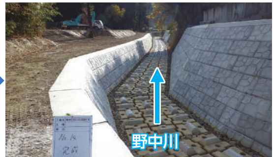
工事完了後 (令和3年3月撮影)
