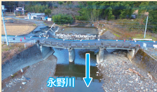
工事前 (令和元年10月撮影)
