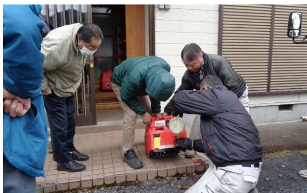
LP ガス発電機の点検→
