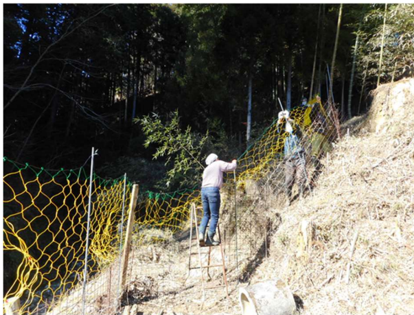
フェンス設置の様子
