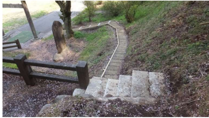
整備された遊歩道
