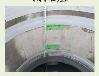
防火水槽満水後、約1週間程度経過し たのち、減水調査を実施します。 減水が発生した場合、減水前の水位ま で給水をして下さい。
