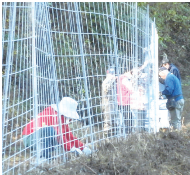
▲布施谷獣害対策会による防護柵設置
