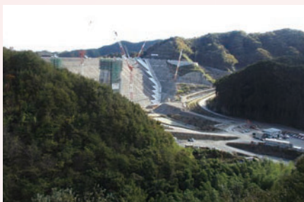
▲南摩ダムの建設
