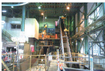
▲設備改良工事の様子
