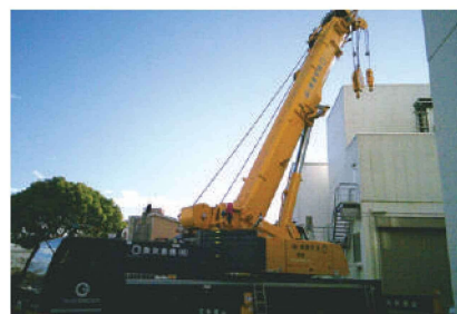
▲大型重機で設備を運搬
