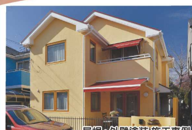
屋根・外壁塗装 施工事例
