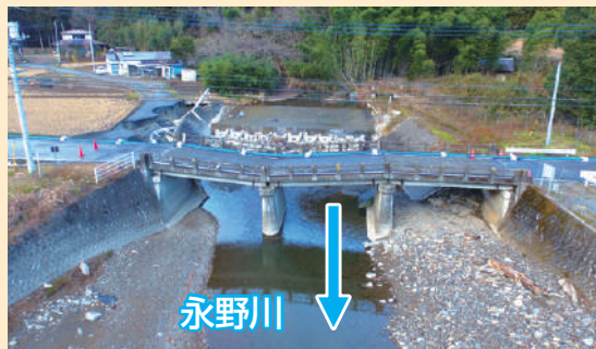
工事前 (令和元年10月撮影)
