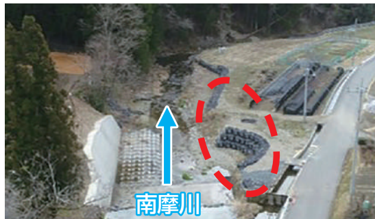
工事前 (令和3年3月撮影)
