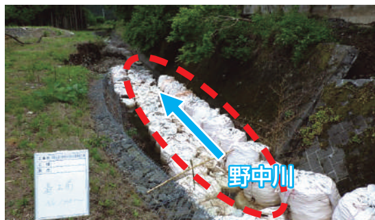
工事前 (令和2年3月撮影)
