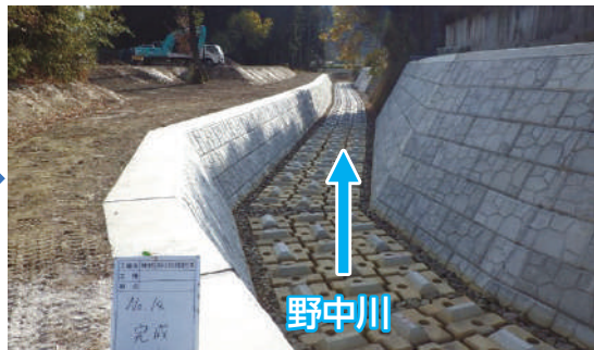
工事完了後 (令和3年3月撮影)
