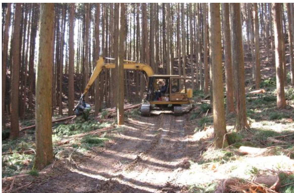
林業機械を利用した搬出間伐作業
