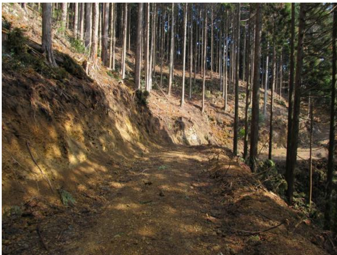
作業路網(栗野地内)
