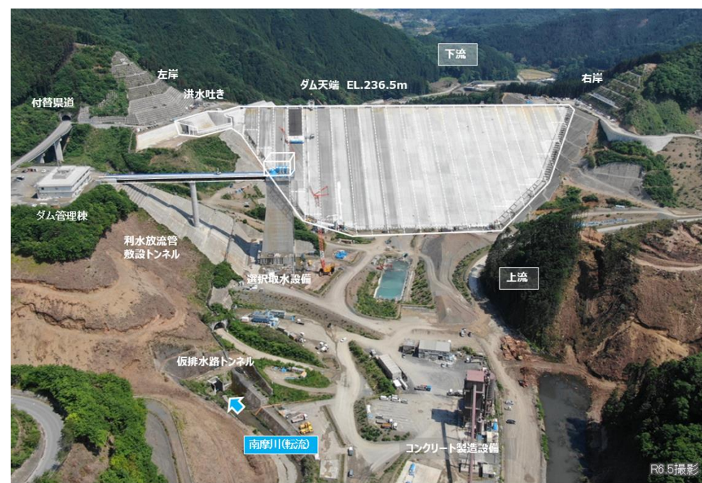
南摩ダム上流から下流を撮影
