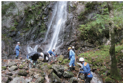
▲大滝遊歩道整備作業
