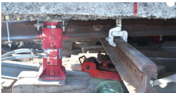
▲ジャッキで持ち上げる建物
