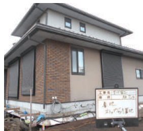
④据え付け・補修
