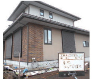
④据え付け・補修
