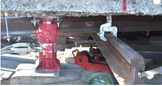
▲ジャッキで持ち上げる建物
