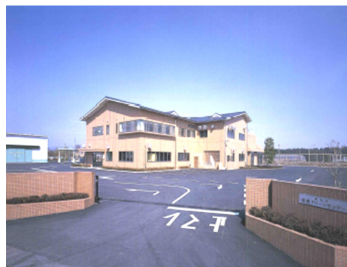
環境クリーンセンター し尿処理施設
