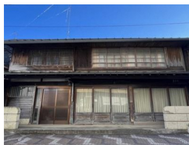
保有している古民家(出典:都市再生機構)
