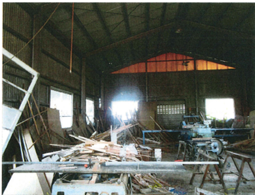
家屋番号 7 番の 2 ・ 附属建物符号 1 の内部の状況
