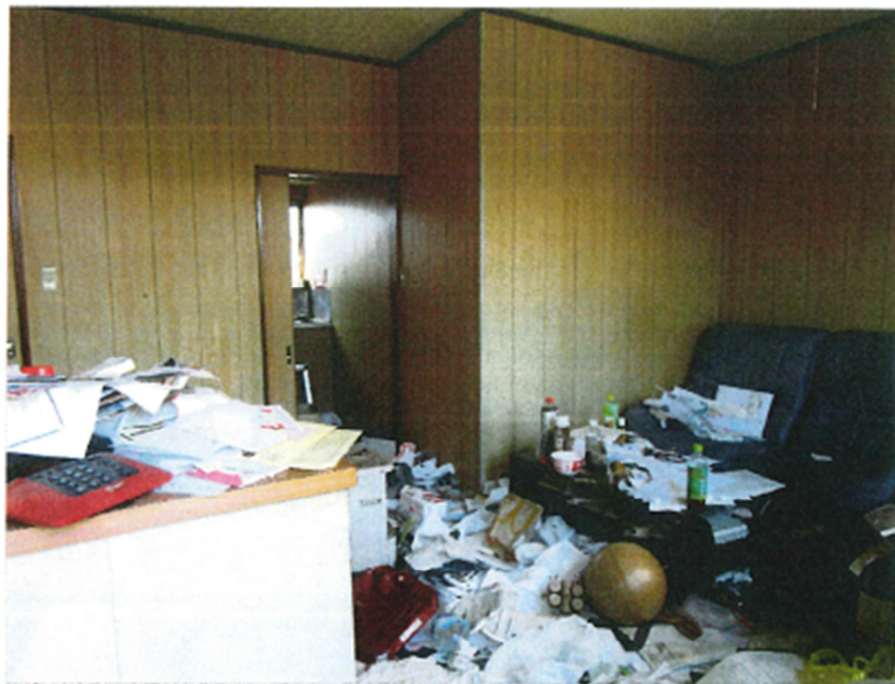
家屋番号 7 番の 2 ・ 主である建物の内部の状況
