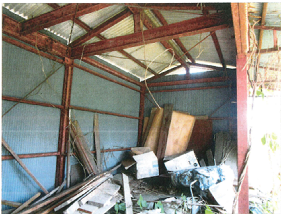
家屋番号 7 番の 2 ・ 附属建物符号 2 の内部の状況
