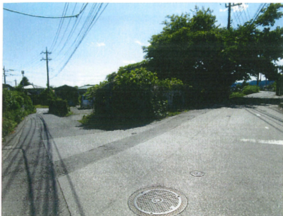
対象不動産を北東側より撮影
