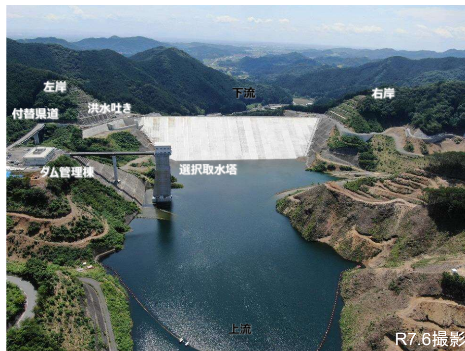
南摩ダム上流から下流を撮影
