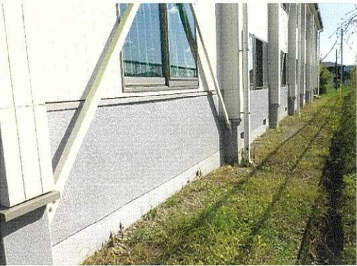
部位 体育館 外部 腰壁
