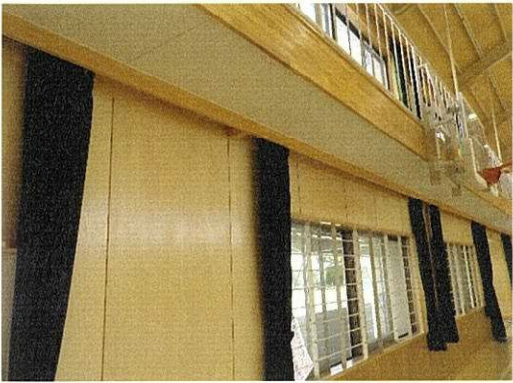
部位 体育館 内部 壁
