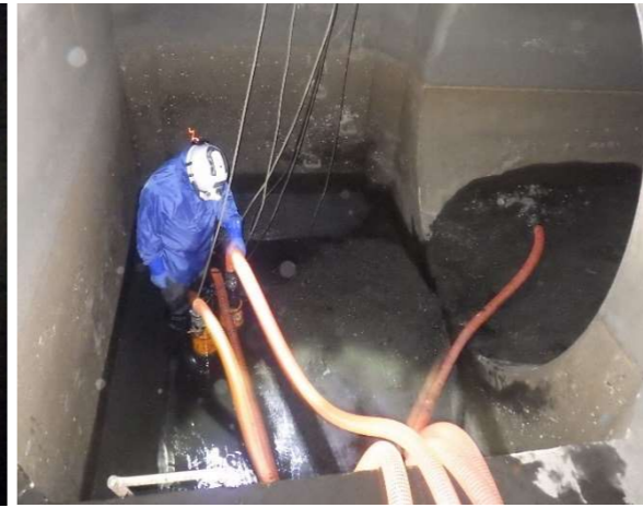
図2 伏越し部排水状況写真
