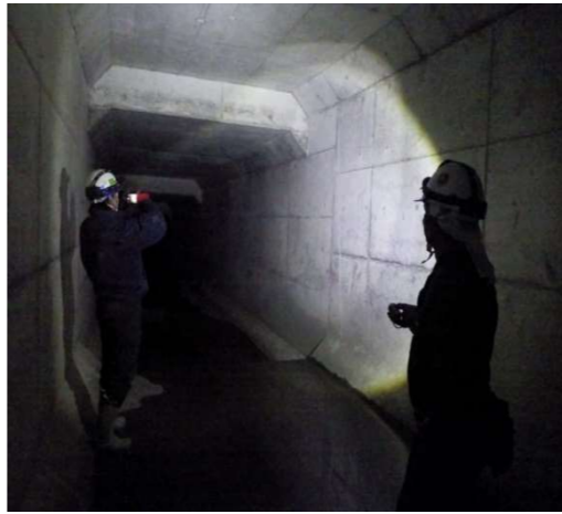
図1 潜行目視調査状況写真
