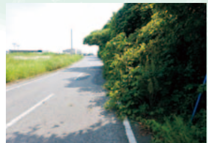
【樹木が張り出しているケース】
