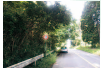
【樹木が道路の上空を覆っているケース】
