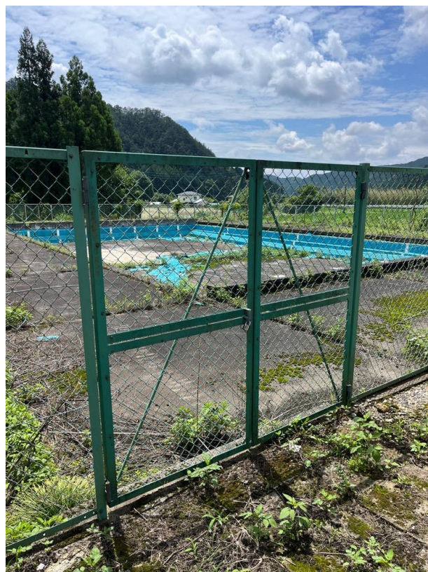
写真④ 25mプール
