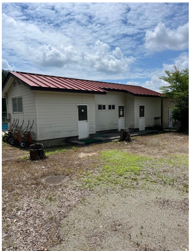
写真③ プール更衣室
