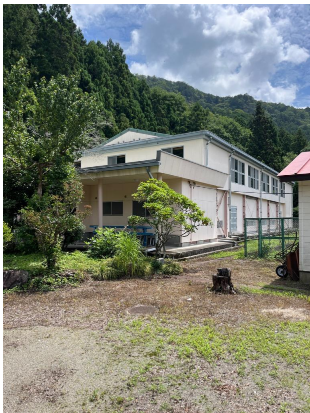
写真② 加蘇中体育館
