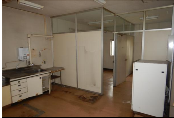
No.8 湯沸室・更衣室
