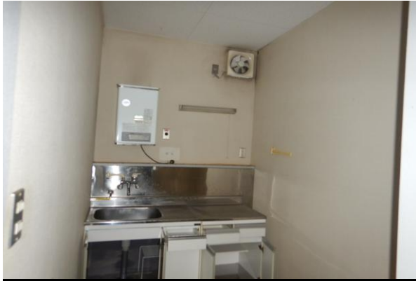
No.13 1階 湯沸室
