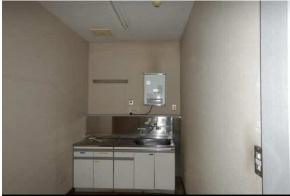
No.19 2階 湯沸室
