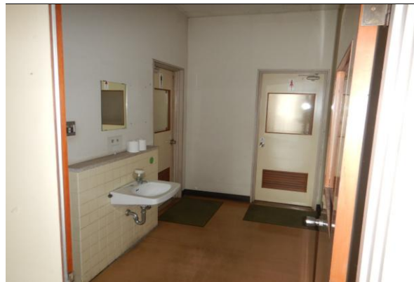
No.11 WC前室
