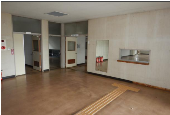
No.10 玄関ホール
