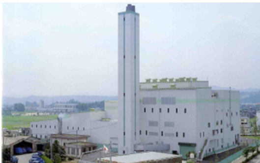
環 かんきょう 境クリーンセンター
