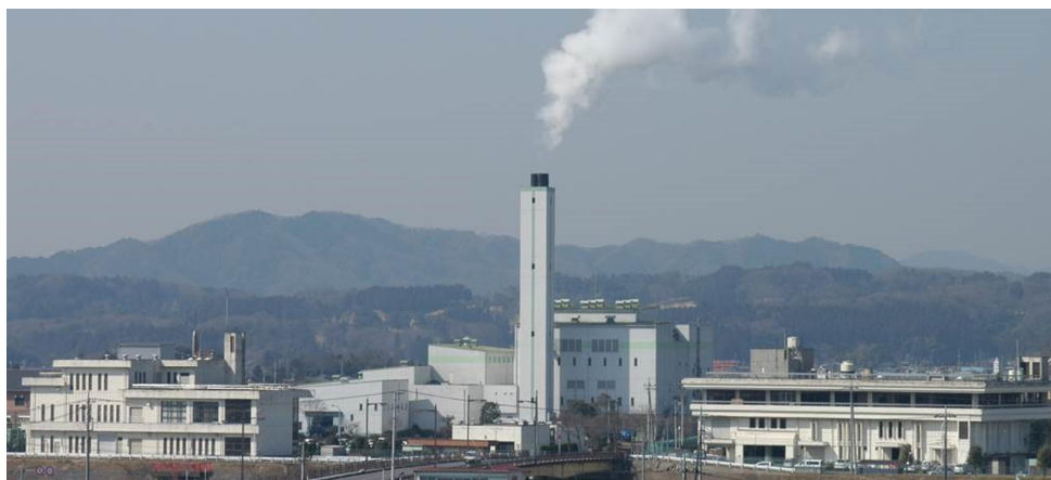
鹿沼市環境クリーンセンター（上殿町）
