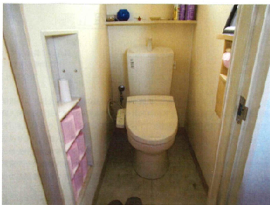
家屋番号1834番5の2の建物内部の状況
