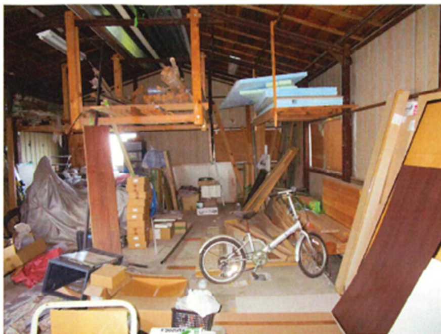
家屋番号1834番5の1の建物内部の状況
