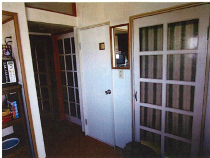
家屋番号1834番5の2の建物内部の状況
