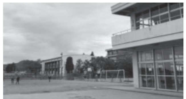
▲給排水設備改修を行う北中学校
