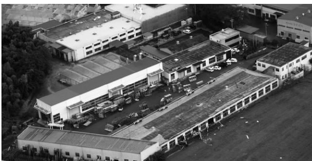
▲平成25年9月4日に市内で発生した竜巻により大きな被害ができました。
