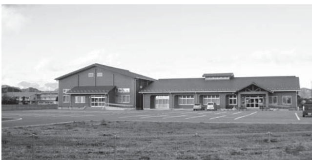
▲平成21年度に新築した北押原コミュニティセンター
