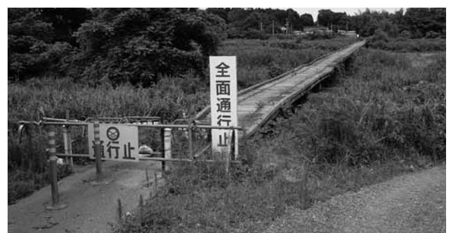
▲被災前の新田橋
