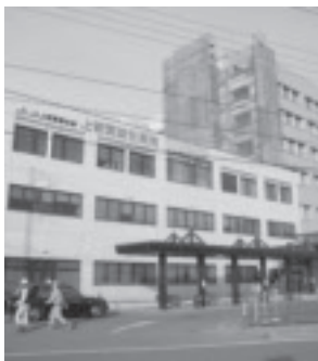
▲建設中の上都賀病院新病院
