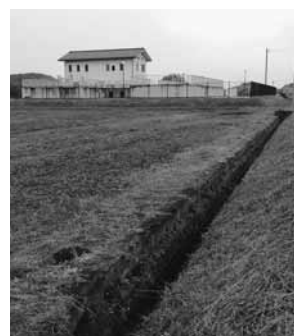
▲農業集落排水処理施設
