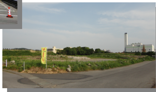
<下水道事務所用地>
