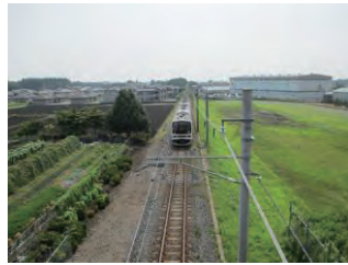
環状線陸橋からのJR日光線
