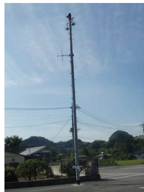
ポール式ホース乾燥塔
