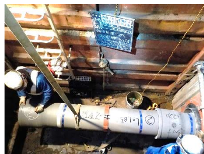
老朽管の更新
