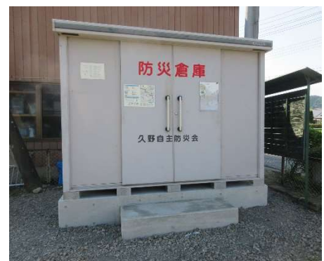
防災倉庫の嵩上げ
