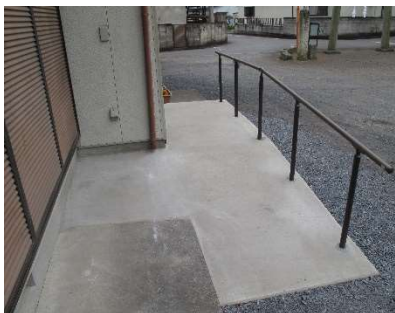
公民館改修(手すり設置)
