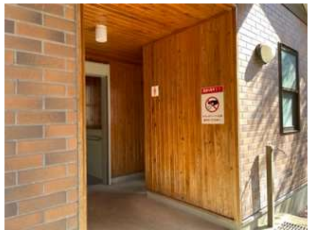
加蘇山神社トイレ(外観)
