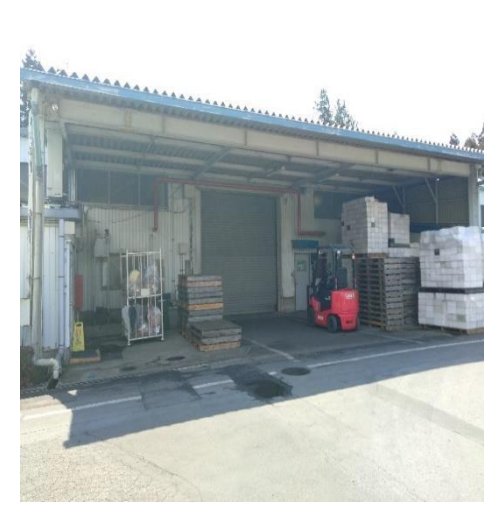
作業施設外観
