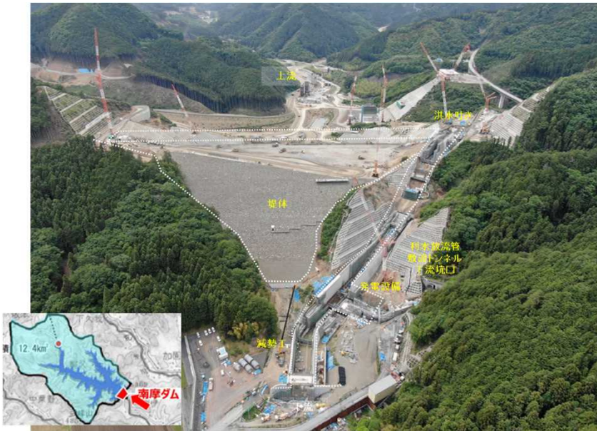
南摩ダム下流から上流を撮影
