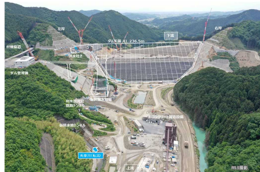
南摩ダム上流から下流を撮影
