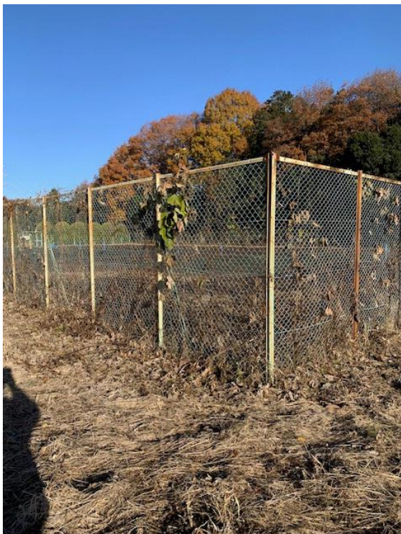
写真③ コート南西角 フェンス状態
